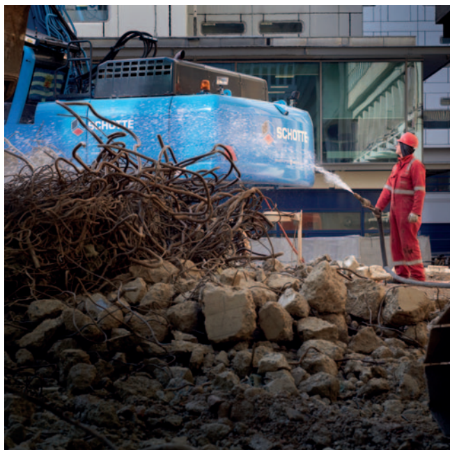
Door water te sproeien tijdens de sloop, vermindert de kans op stofverspreiding.
